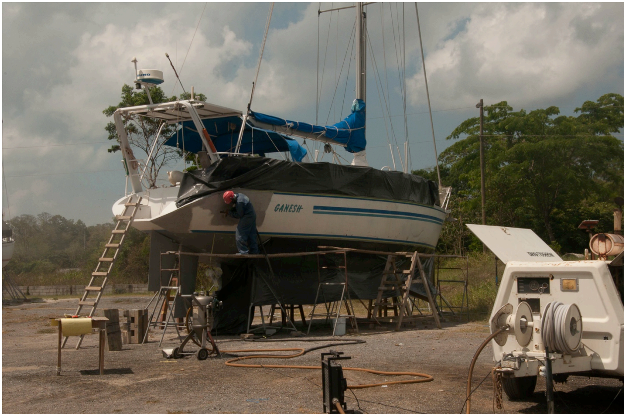
Travaux sur Ganesh à Ram Marina
